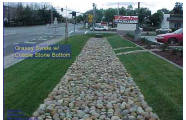
משטחי דשא משופעים מפנים נגר לתעלת פילטר המשמשת לאצירת והחדרת הנגר
